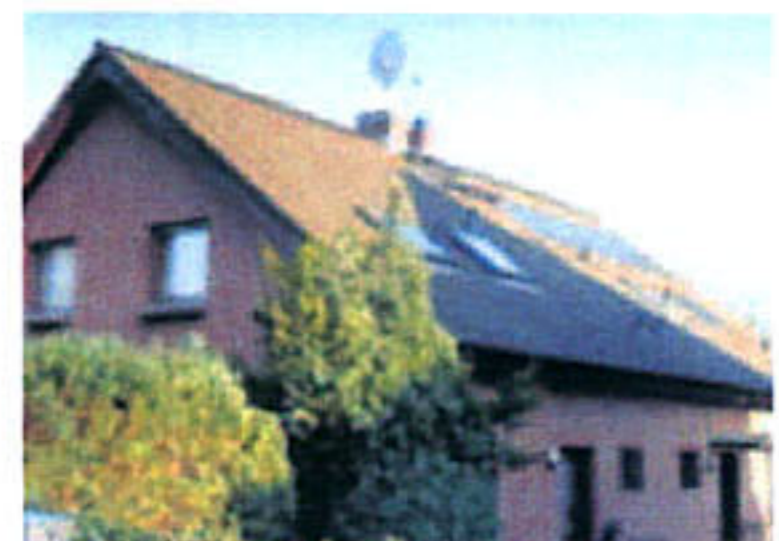
Lohnt sich nicht: die Fotovoltaik-Anlage auf dem Haus der Caspers.
