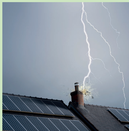
Dachanlage bei Blitzschlag
