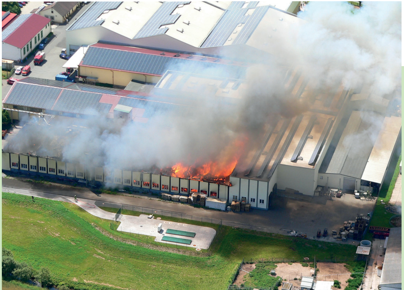
Brennendes Gebäude mit PV-Anlage
