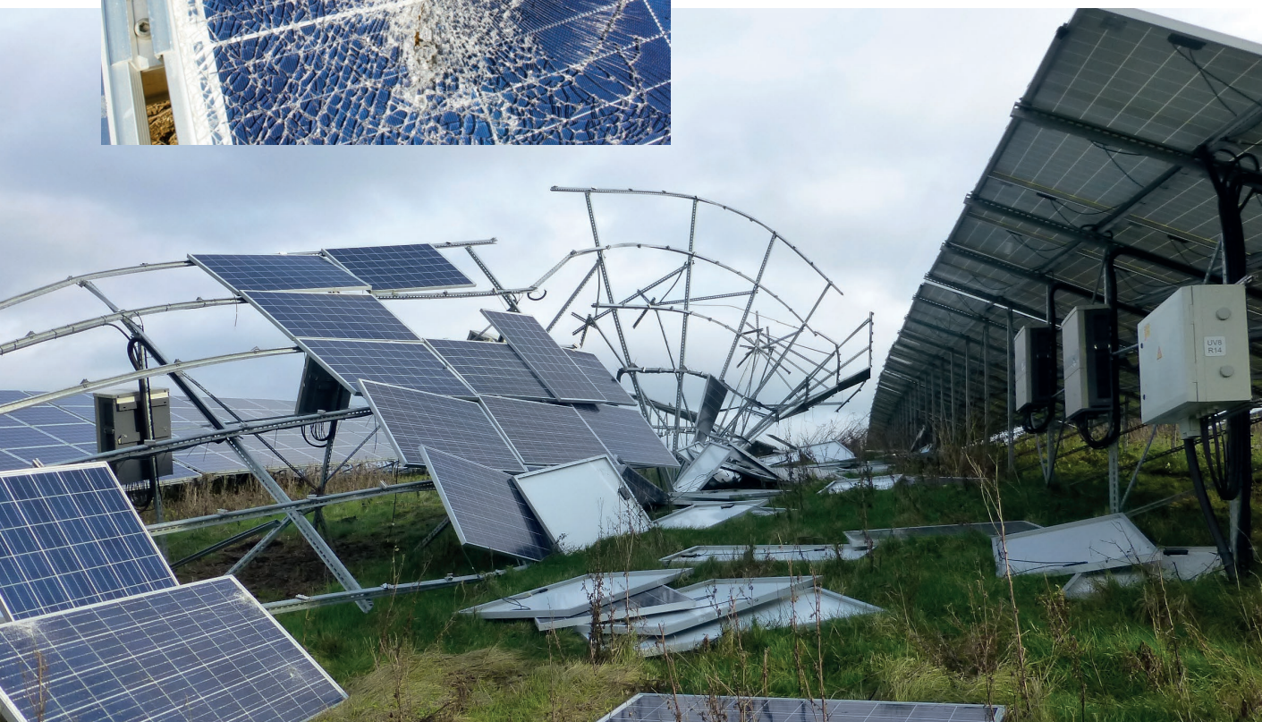
Freiflächen-PV-Anlage nach einem Sturm
